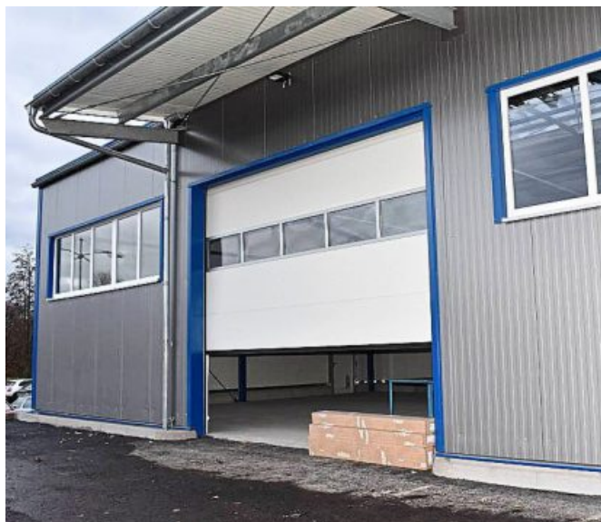
Das ist die neue Lagerhalle für Teile. Hier wurde ein Teil der 2,5 Millionen Euro Investitionen verwendet.
